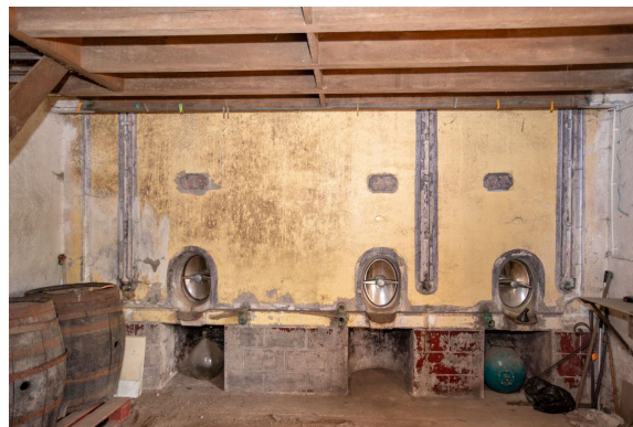
Cuves du négoce Defontaine, Le Pallet
