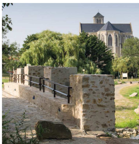
Le pont après restauration © Commune de Mouzillon
