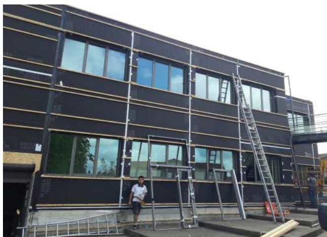
Remplacement des murs rideaux de l'hôtel de ville, par un mur ossature bois
