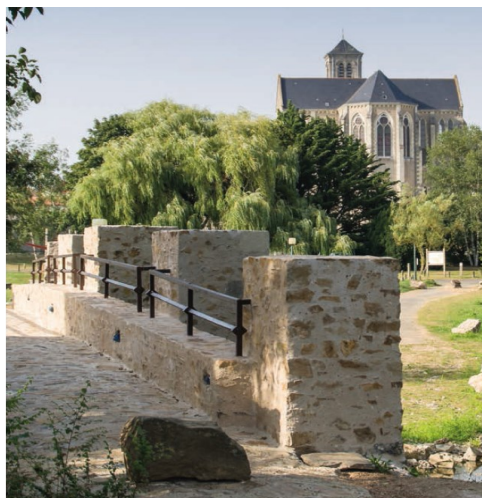
Le pont après restauration © Commune de Mouzillon
