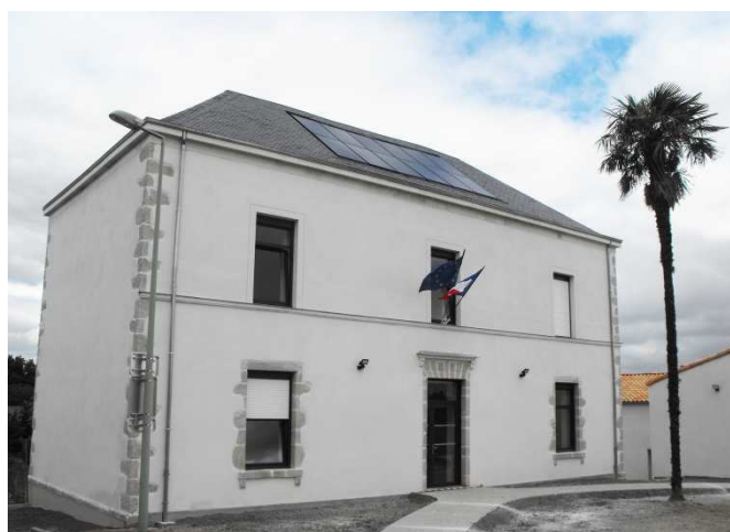
La nouvelle mairie de Monnières © Commune de Monnières
