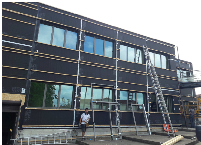
Remplacement des murs rideaux de l'hôtel de ville, par un mur ossature bois
