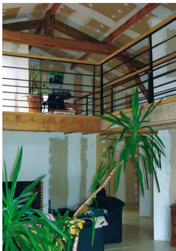
Ancienne grange à une nef en cours de rénovation - La Chevrolière
