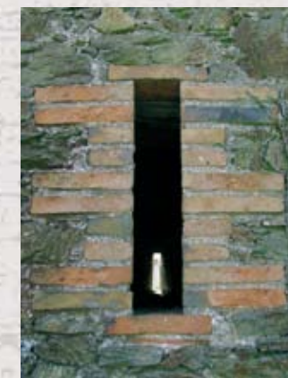
« meurtrière » de ventilation
