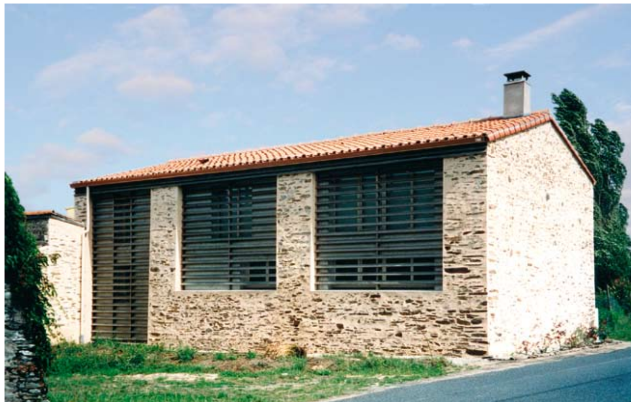
ancien grange - Saint Julien-de-Concelles
