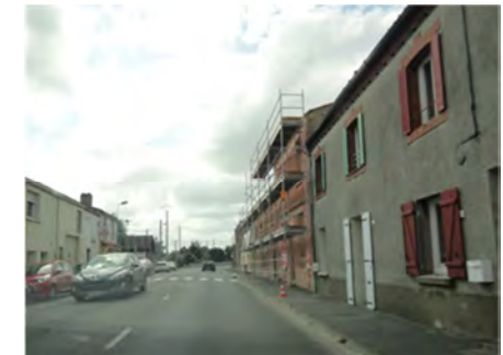
Bâtiment en cours de rénovation, Le Pallet
