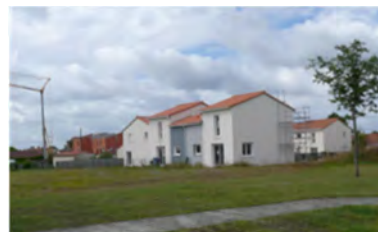
Bâtiment en cours de réfection, Le Loroux-Bottereau
