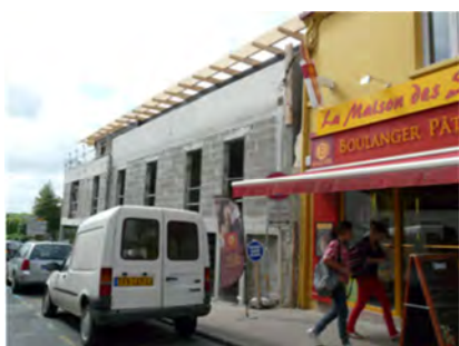
Bâtiment en cours de réfection, Le Loroux-Bottereau
