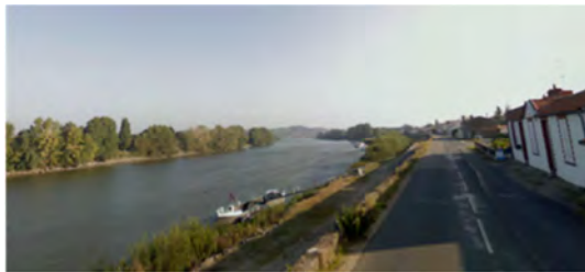
Vue sur la levée de la Divatte au niveau de la commune de La Chapelle-Basse-Mer
