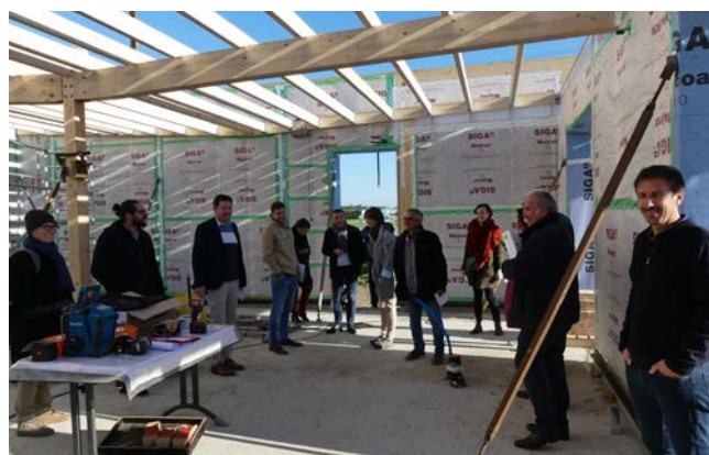
Visite par le comité LEADER et des communes du pays, du chantier de construction du nouvel « Espace Jeunes » de La Planche, bâtiment éco-construit (octobre 2021)
