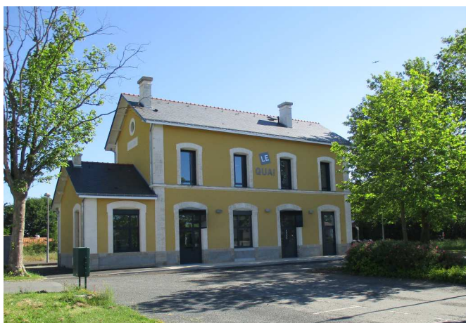
La halte ferroviaire de Boussay réhabilitée accueille le pôle socio-culturel « LE QUAI » © Commune de Boussay
