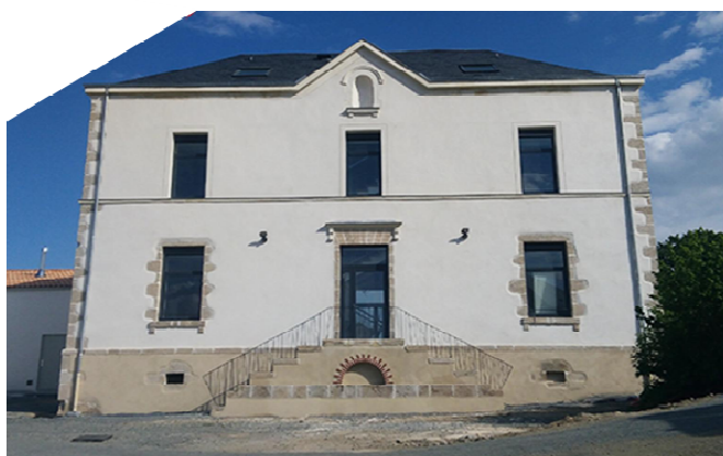
La nouvelle mairie de Monnières
